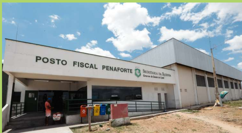
Novas instalações do Posto Fiscal de Penaforte
