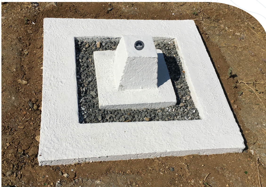
Figura 1 – Exemplo de marco de referência geodésico construído na barragem Aracoiaba (acima) e receptor geodésico utilizado nas leituras dos marcos de recalque na barragem Germinial (abaixo)
